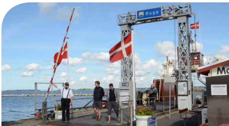
Portalerne ved færgelejerne er de gamle nittede konstruktioner.
