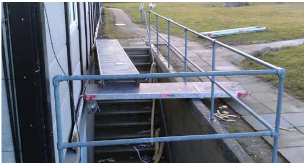
Kunstnerisk opstilling med alvorlige perspektiver. Alt tegner dog til at stilladset tilhører kategorien af "tilfælde hvor det gik godt". Fotos: Ib Skoubo
